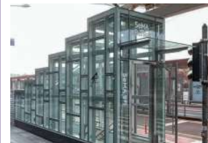
YEUIDO SeMA BUNKER SeMA방커
